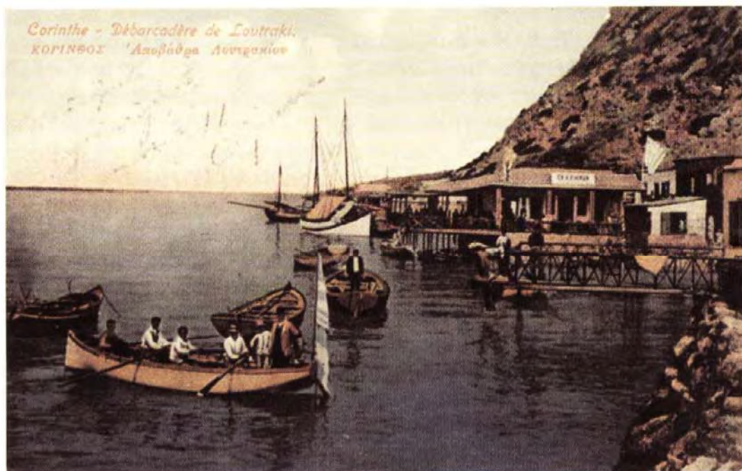
Ο σταθμός μετεπιβίβασης στο Λουτράκι
