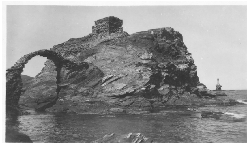
15. ΑΝΑΡΟΣ Γέφυρα Μέσα Κάστρου ANDROS Le pont Messa Kastrou
